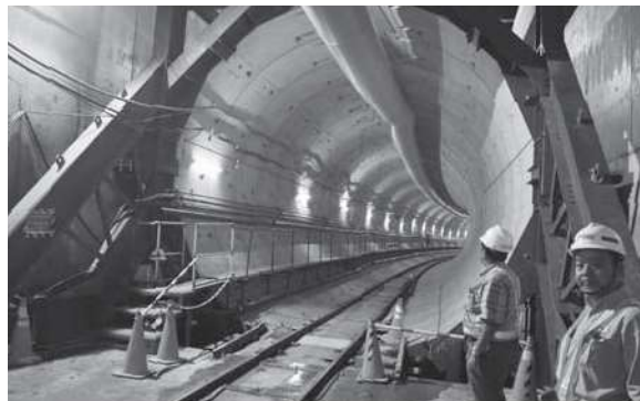
ジャカルタ市内のMRT工事現場（=JICA提供）
